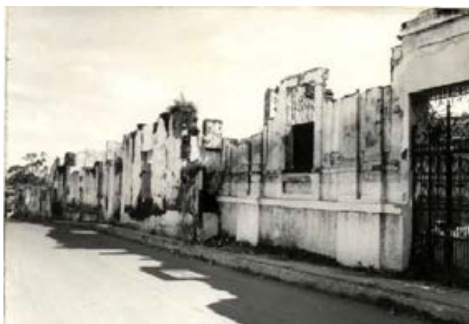
Ruinas de la Real Casa de Moneda de Popayán luego del terremoto de 1983
